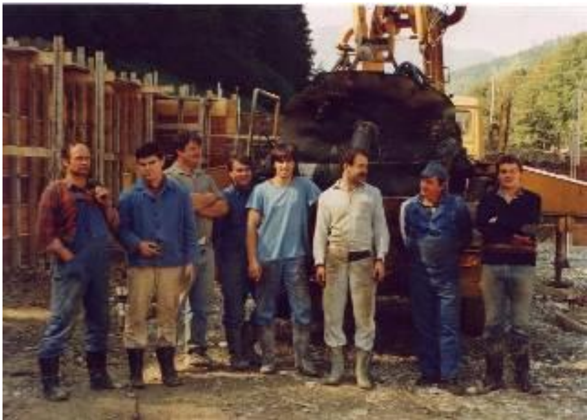
Akcija: izdelava betonskega opornega zidu 1989
