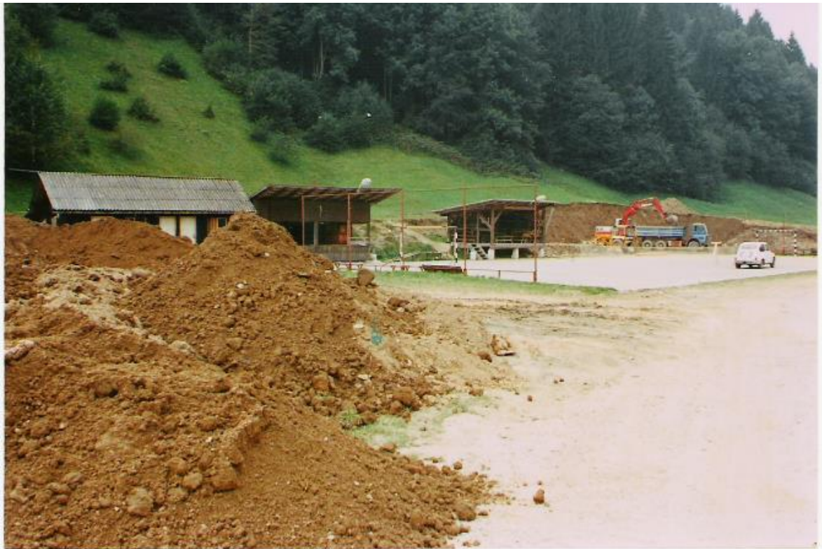
Izkop zemlje za tenis igrišče 1989
